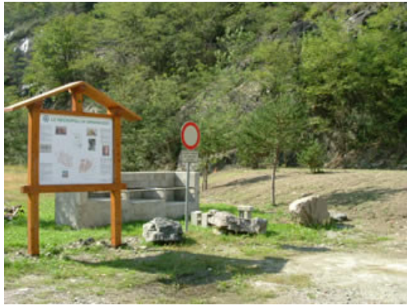
Proseguono i lavori di sistemazione dell'area di sosta alla partenza della Linea Cadorna.
