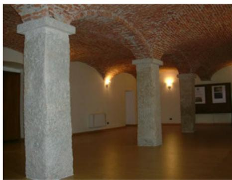
Nella foto gli ambienti della nuova Sala Prove dopo la ristrutturazione, con pavimento in legno, nuova illuminazione e impianti, volte in mattone e pilastri in granito
