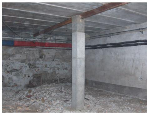
Una foto del locale Sala Musica prima della ristrutturazione. L'intervento di recupero ha comportato l'eliminazione di un pilastro centrale della sala per realizzare l'ambiente per la sala prove
