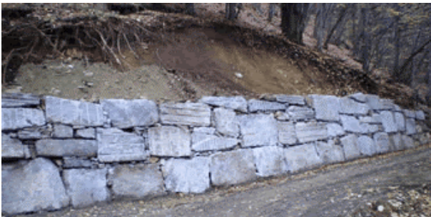
Nella foto il nuovo muraglione di contenimento del terreno franoso all'imbocco della strada per gli alpeggi
