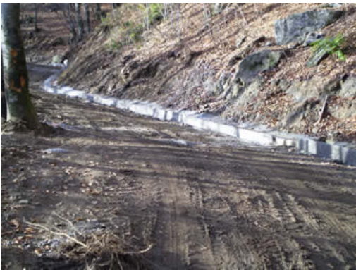
Nelle foto i lavori di canalizzazione e raccolta di acque piovane al Schirombei
