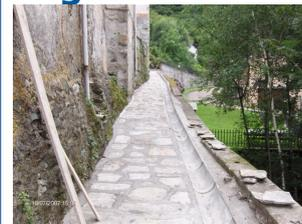
Un ringraziamento particolare all'Assessore Claudio Lavarini per l'assistenza tecnica fornita ai lavori di sottomurazione e drenaggio delle fondazioni dell'abside posteriore e altare della Chiesa di Migliandone con sistemazione dell'area esterna mediante la pavimentazione, pulizia muri e convogliamento delle acque di scarico meteoriche (nella foto). I lavori sono stati finanziati dalla Parrocchia di Migliandone.
