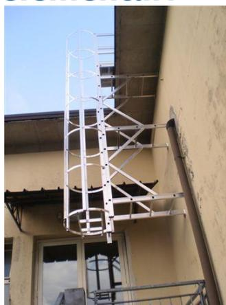
Nel mese di Ottobre è stata installata la nuova scala per accedere al tetto delle scuole elementari per l'ispezione e la manutenzione dell'impianto solare fotovoltaico per la produzione di energia elettrica installato dall'Amministrazione comunale sul tetto della scuola.
